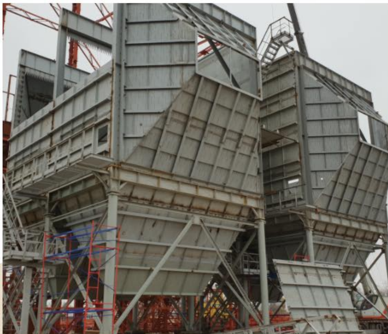
Два двухпольных электрофилтра
